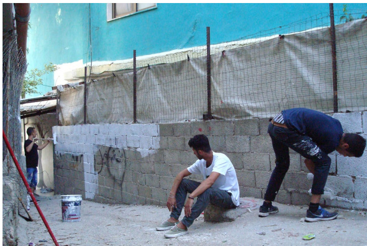
TROIS PEINTRES PROFITENT DU RESTE DE PEINTURE POUR RECOUVRIR DE BLANC UN MUR EN PARPAINGS GRIS (© CL 2016).
