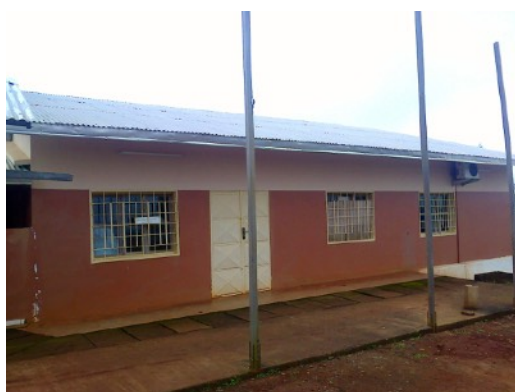
Image 7 : Le bâtiment du service d'imagerie médicale avec sa nouvelle porte d'entrée Crédits image : Nicolas Mabillard
