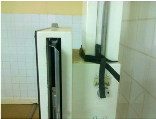
Image 29 : Tige de caoutchouc maintenant le porte détecteur et son axe. Crédits image : Nicolas Mabillard
