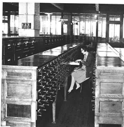
Vue d'une section du bureau du courrier en 1928
