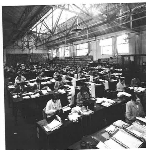
Vue d'une partie du bureau du magasin des pièces de rechange
