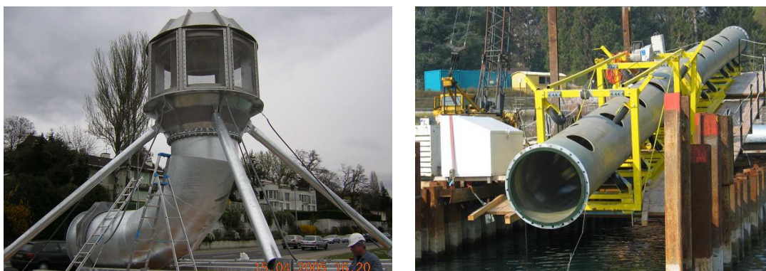
fig. 6-3 Crépine d'aspiration (à gauche) et diffuseur de rejet (à droite) (source: SIG)
