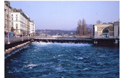
Figure b: Pont de la Machine à l'époque où la régulation du Léman s'effectuait par des rideaux installés sous le pont. Cette construction, comptant 39 rideaux en bois de mélèze, fût construite en 1887 (photo: vue depuis l'île de Bel-Air, 1988. Coord. du bâtiment SIG 500 140/117 960).
