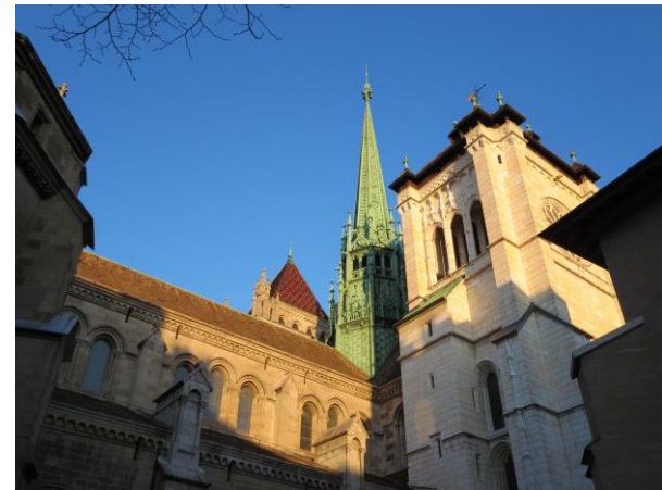
Figure b: Cathédrale Saint-Pierre, tours construites en calcaire blanc et nef construite en grès de Molasse.
