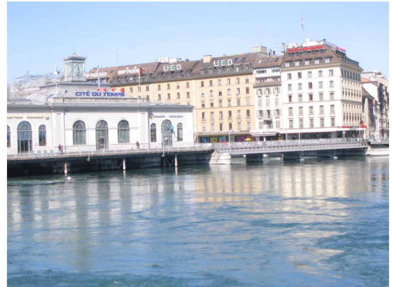
Figure e: Pont de la Machine, lieu d'installation des pompes d'eau courante en 1843 (coord. du bâtiment SIG 500 140/117 960).
