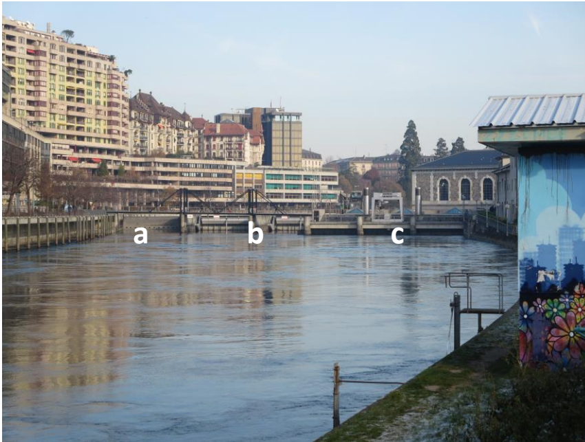
Figure c: barrage et écluse du Seujet; vue depuis la rive gauche, en aval. a) écluse, b) vannes de régulation du débit du Rhône et du niveau du Léman, c) turbines.
