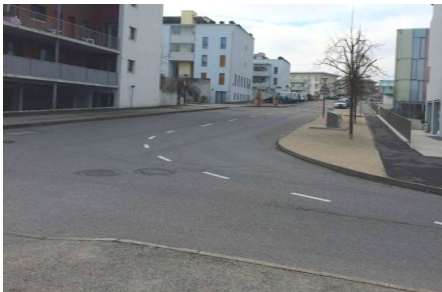
Figure 9 : Le coude de la rue Edouard-Vallet. La vue étant bien dégagée des deux côtés du virage, les piétons n'hésitent souvent pas à le traverser malgré l'absence de trottoir. Source : Valérie Corminboeuf, janvier 2015
