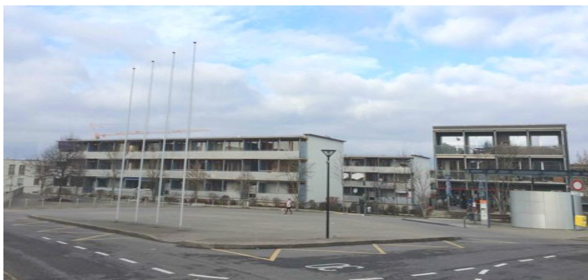
Figure 14 : La place centrale vue depuis son entrée nord. Nous pouvons remarquer la forte dominante minérale, l'omniprésence de la route sur deux des quatre côtés de la place ainsi que les aménagements liés à la fonction de terminus de bus TPG (marquage au sol, distributeur de billets, etc.).
