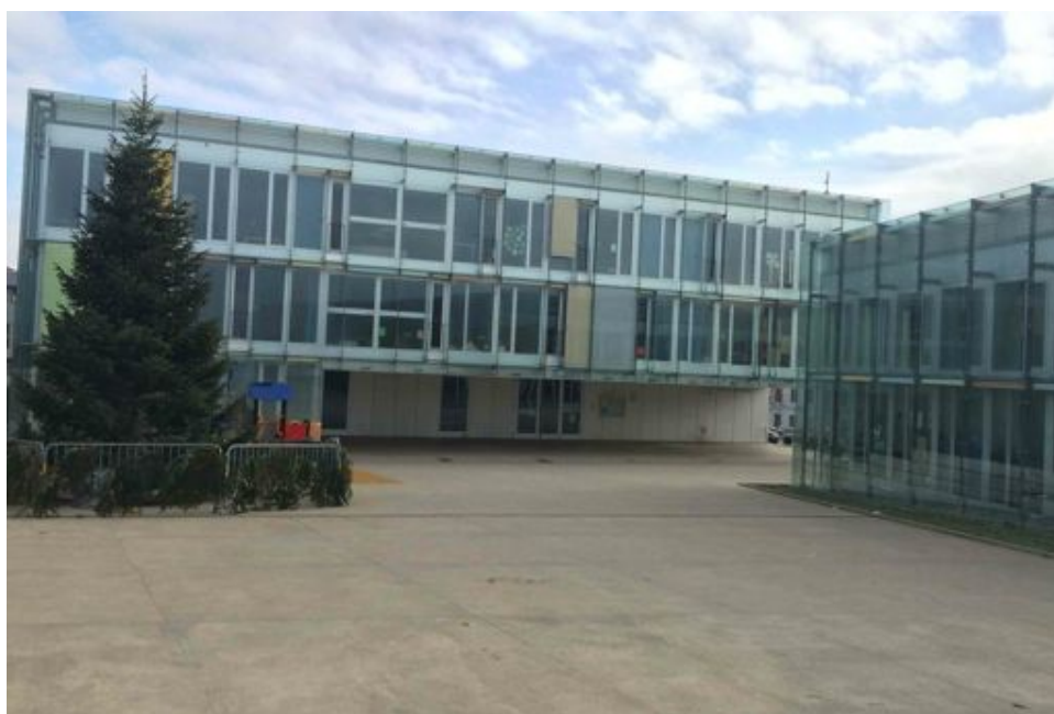
Figure 16 : Le préau de l'école. La surface du préau est plane, dégagée et grande ; il est facile d'y organiser des activités de quartier et accueillir un grand nombre de personnes. Source : Valérie Corminboeuf, janvier 2015
