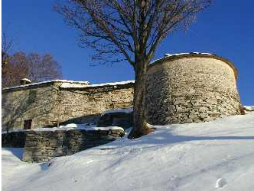
Fig. 1 : La nevèra (à droite) est un bâtiment de forme cylindrique, enterré pour les deux tiers, avec un toit conique en pierre. Fort présents sur les alpages du Monte Generoso, les nevère caractérisent le paysage rural. Dans cette région karstique, l'eau de source est rare et l'élément réfrigérateur est la neige.
