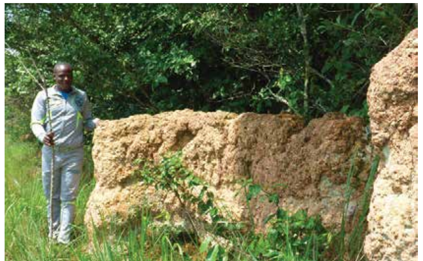
Fig. 15 : Hauteur d'une portion restante de la muraille de Fomban, 2018.
