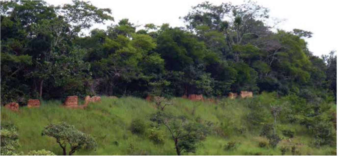
Fig. 13 : Aperçu des vestiges de la muraille de Fomban dans le paysage, 2018.
