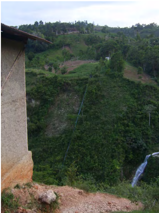
Figure 14 : Conduite forcée alimentant la turbine.
