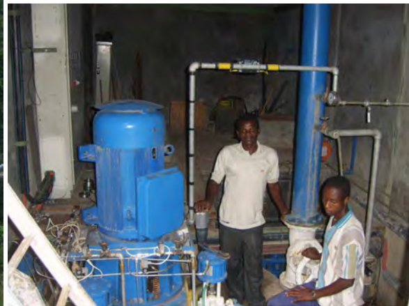
Figure 15 : Turbine hydroélectrique
