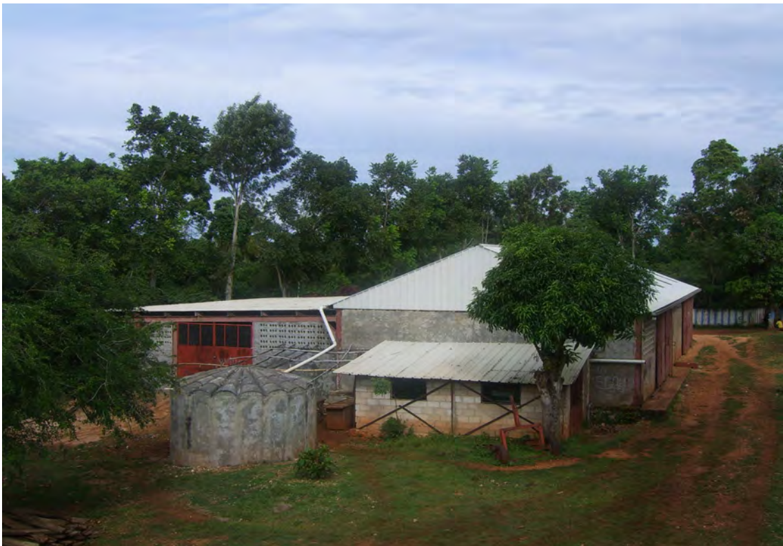
Figure 9 Bâtiments des ateliers de ferronnerie et d'ébénisterie
