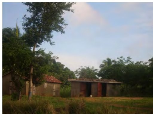
Figure 8 : Cantine scolaire à gauche et cuisine à droite
