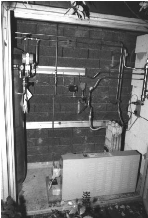
Figure 7: Ballon collecteur (qui apparaît sur la gauche de l'image) et compresseur (par terre).
